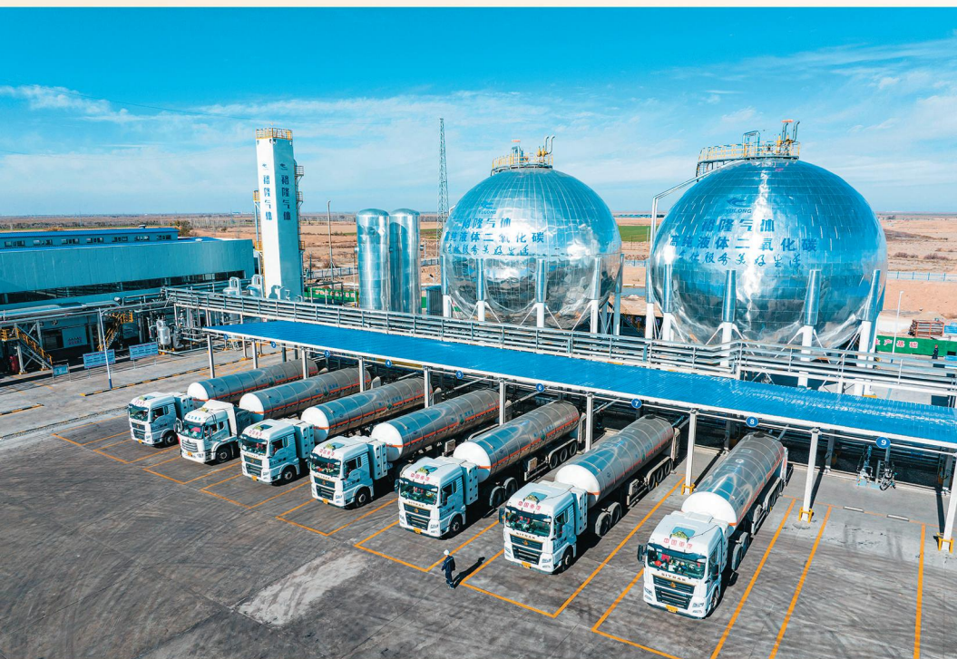
新疆奇台县喇嘛湖梁工业园区新疆裕隆丰源气体有限公司二氧化碳捕集生产与提氢装置投料试车成功。
