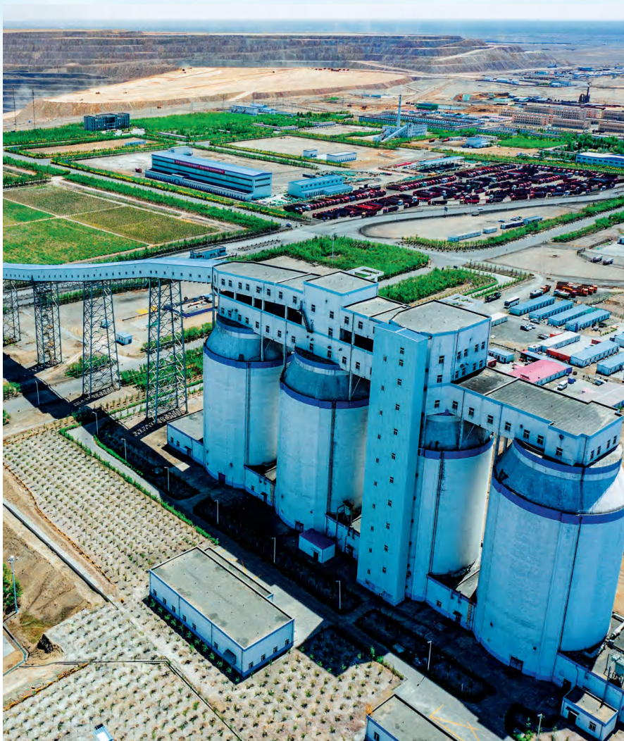
特变电工天池能源公司南露天煤矿的全疆首套直装式筛分楼和室内分流站。
