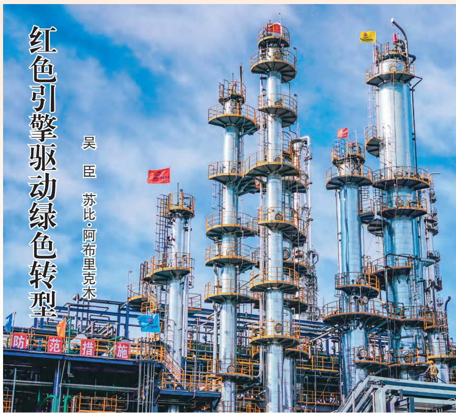
伊吾工业园区新疆宣东能源有限公司施工现场。
