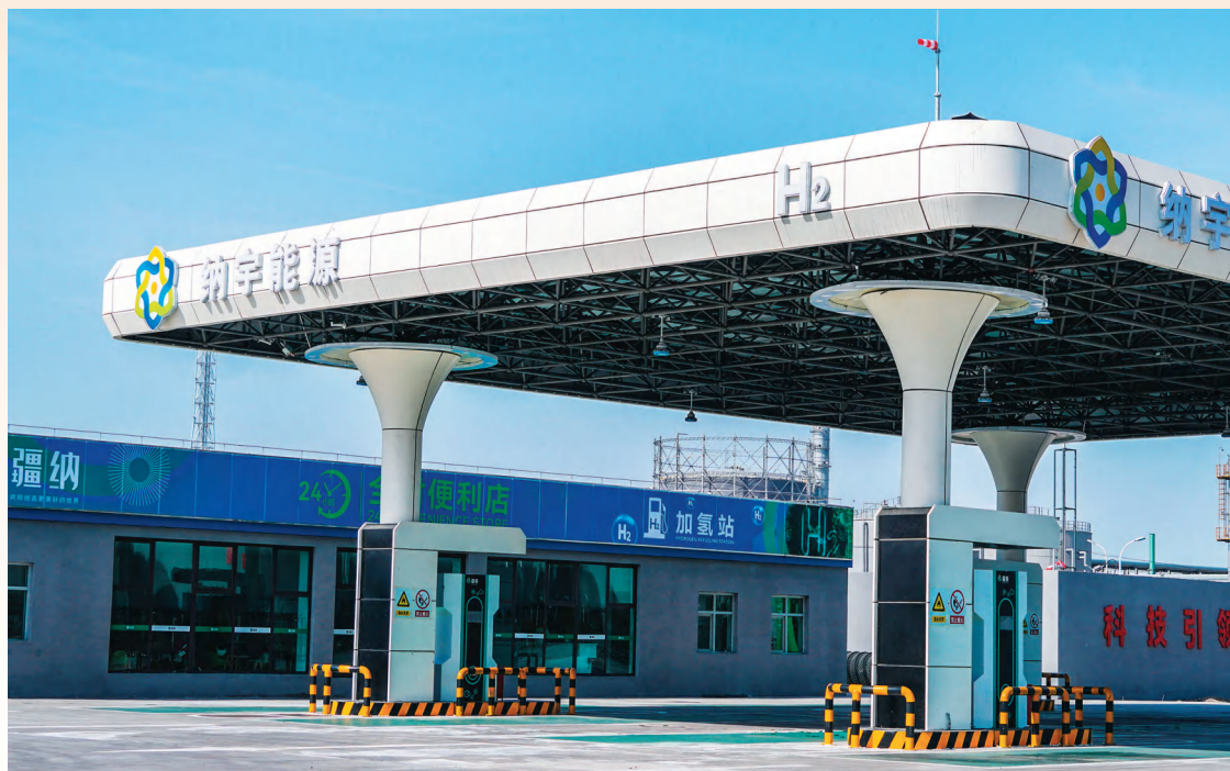
伊吾纳宇氢能科技有限公司加氢站外景。
