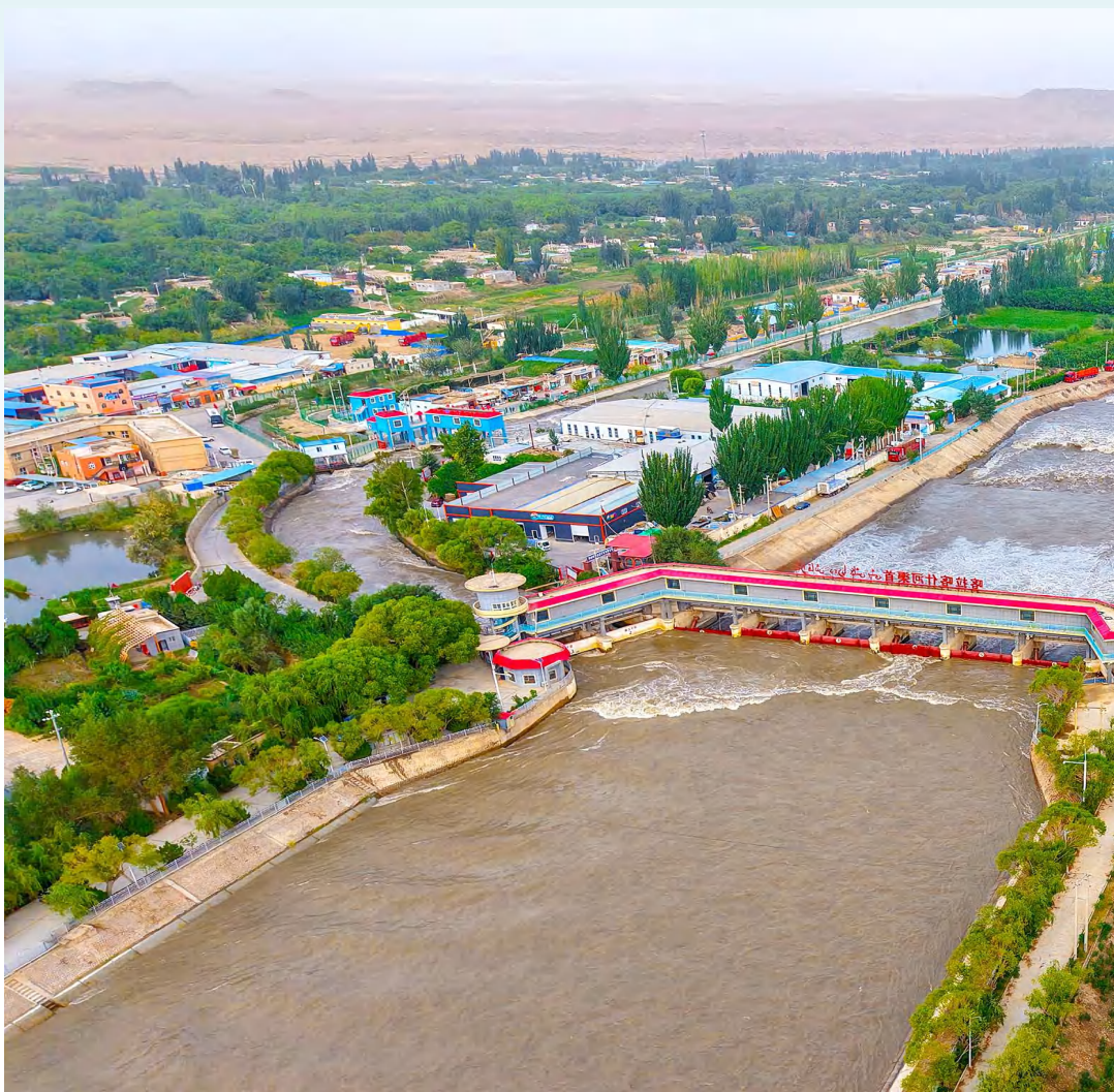
位于墨玉县萨依巴格乡渠首村的喀拉喀什河渠首工程。
